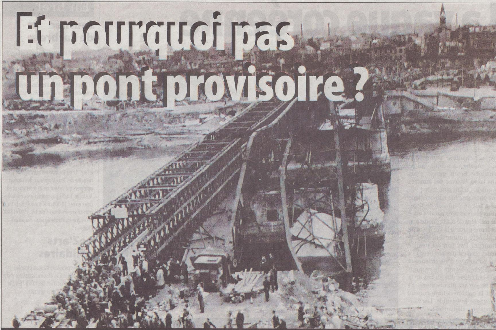
Septembre 1944, pont Boieldieu. En 48 heures, un pont de type Bailey est construit sur les piles de l'ancien pont. Une solution pour le pont Mathilde ?
