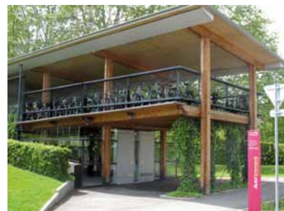
Les garages à vélos peuvent être pratiques et esthétiques. Strasbourg compte plus de 22 000 places de stationnement pour les cycles et en ajoute 1300 à 1500 chaque année.
