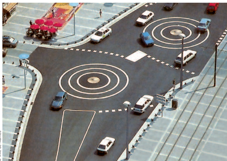
Fig. 6. Exemple de double rond-point sur le cours des 50 Otages à Nantes.
