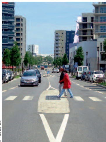
Fig. 3. Un refuge piéton rue du Général de Bollardière à Nantes.
