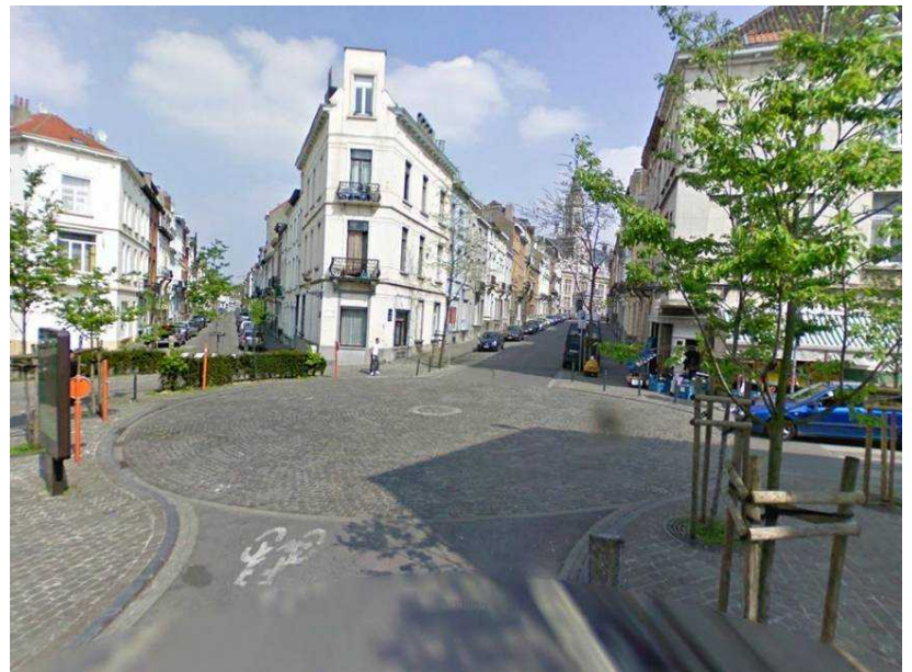
Réaménagement de carrefour avec fermeture partielle et rupture visuelle de la continuité de l'espace de circulation.
