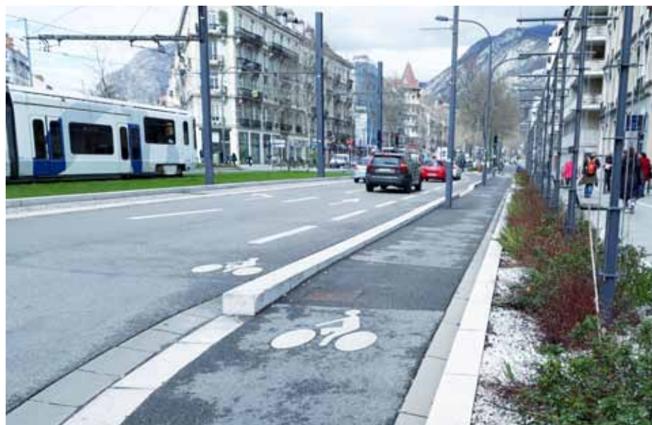
Laisser le choix entre la bande et la piste cyclable, détail d'une collectivité favorable au vélo (photo L. Picado)
