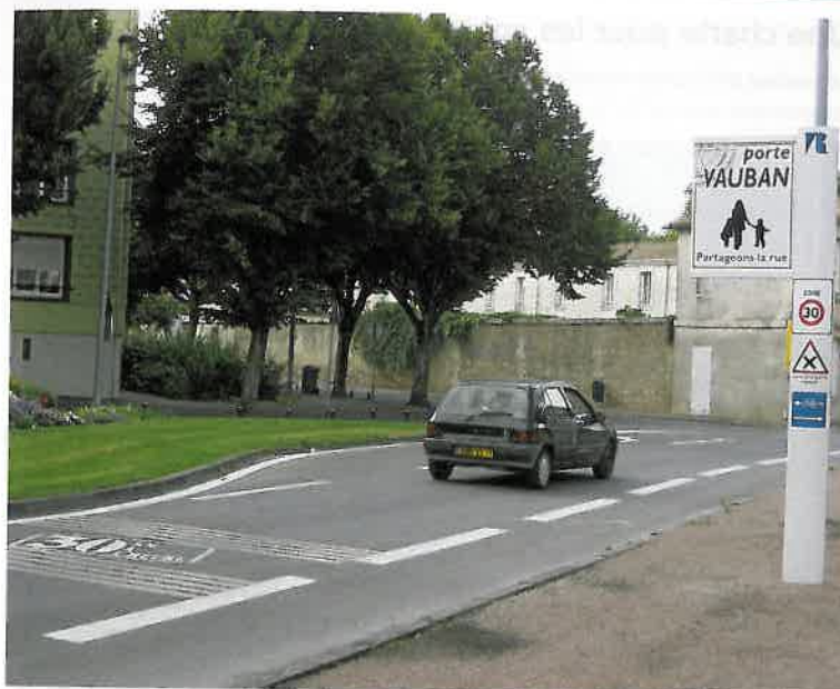
Figure 2. Un exemple d'aménagement léger pour les entrées de zone 30 à Rochefort (photo Yan Le Gal).
