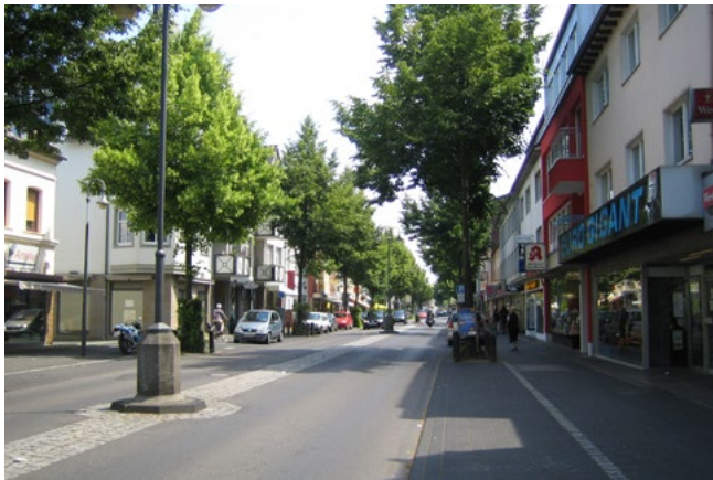
HENNEF : première opération de rétrécissement de voirie destinée à ralentir la circulation (1972)
