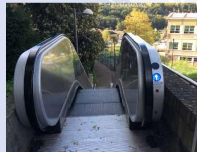
**Un quatrième couloir mécanisé, utilisé principalement par les étudiants qui se rendent à Sienne en bus, relie la zone d'échange de Via Pescaia avec deux escaliers mécaniques, et sort dans la zone de la Fortezza, en utilisant un ascenseur vertical.**
