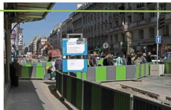
Enceinte de chantier de voirie avec information au public conforme
