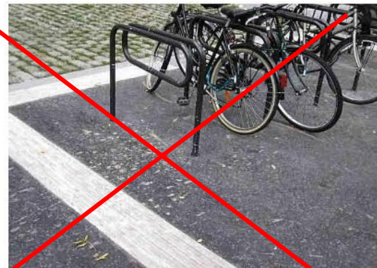
Principe de repérage du stationnement deux roues sur trottoir par la mise en place d'une bande visuelle et tactile d'accompagnement.
